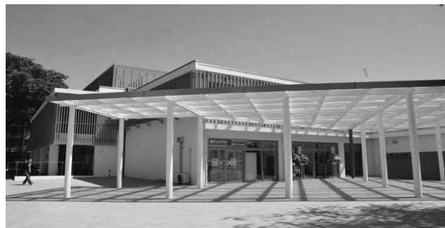
工学部総合会館
